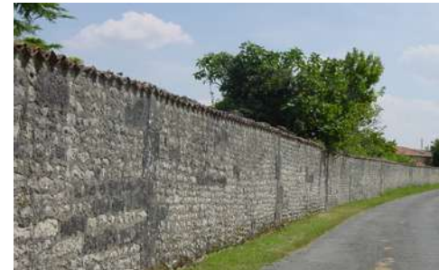
Les murs de clôture en pierre doivent être maintenus
