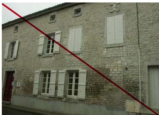
Façade non enduite : seules les structures en pierre de taille devraient rester apparentes
