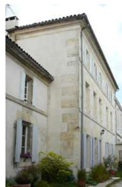
L'enduit devrait affleurer le nu des pierres, sans surépaisseur
