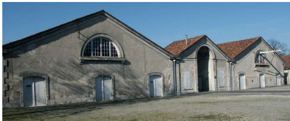
Les chais de Cognac ont été identifiés et protégés dans le cadre de l'AVAP de Cognac. La charte donne des préconisations pour leur mise en valeur et rénovation.
