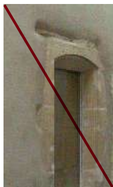
L'enduit devrait affleurer le nu des pierres, sans surépaisseur
